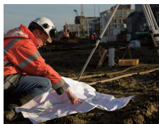
建設・工事現場での業務連絡
