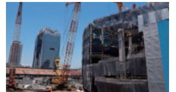
建設現場の作業連絡
